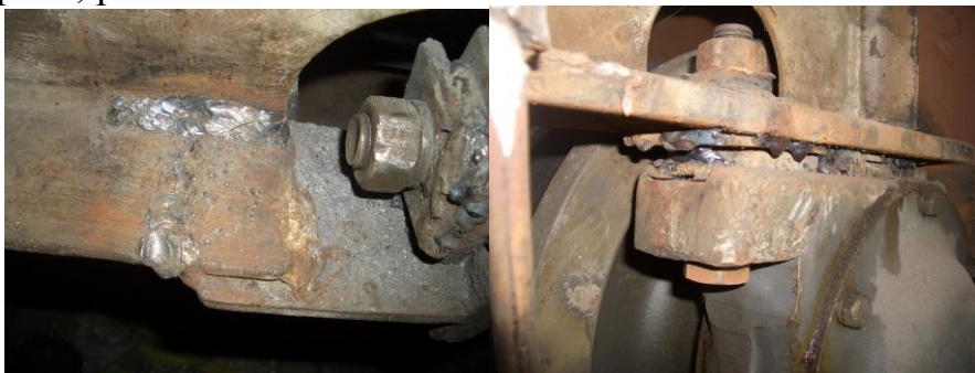
Рис.1и 2 Результаты неквалифицированного ремонта околобуксовых зон мостового крана
